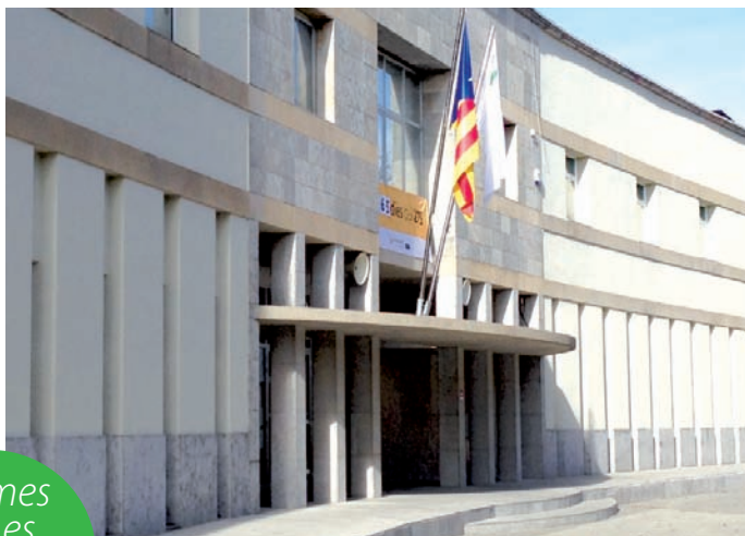
Ajuntament de Calldetenes Rehabilitació de façana 1r trimestre 2015
