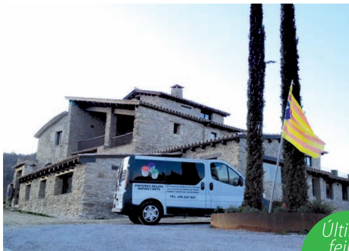
Masia Catalana a Malla Rehabilitació i protecció de fusta 1r trimestre 2015
