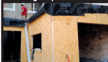
Construccions amb fusta
